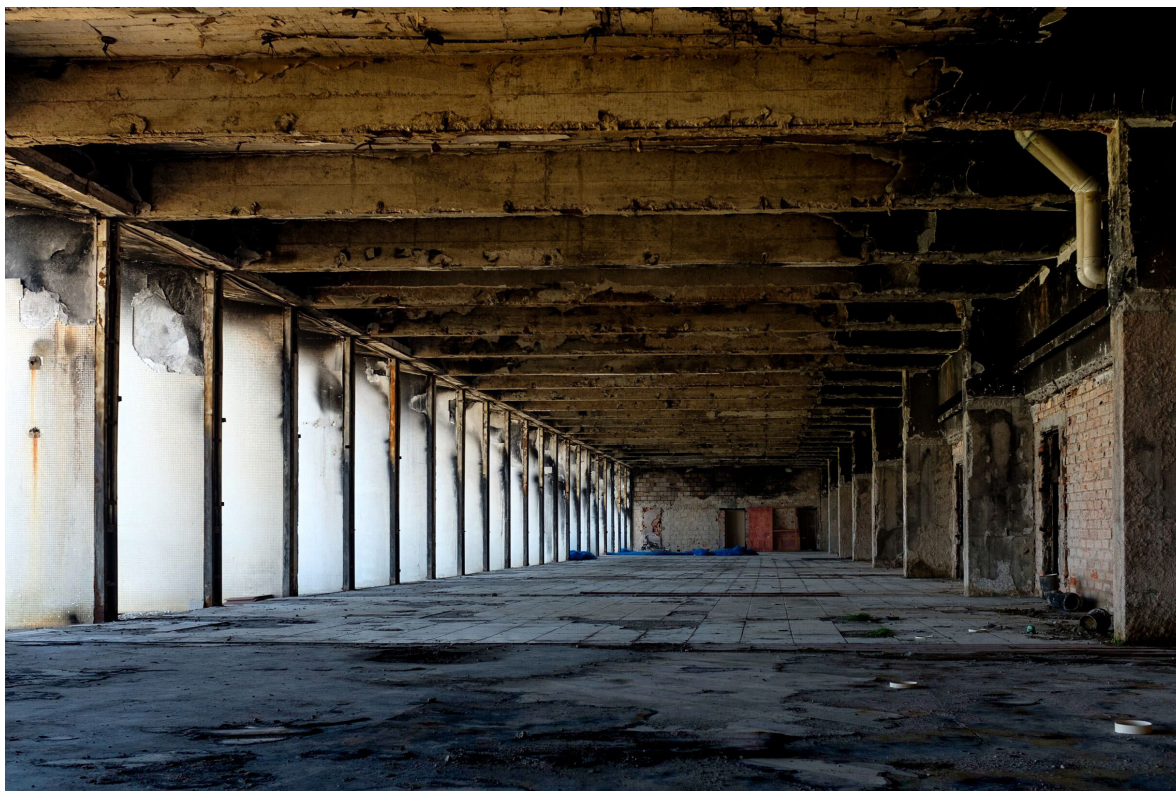
FIGURA 26- Edifício Jorge Machado Moreira. Salão e circulação do oitavo pavimento após incêndio, 2017.
